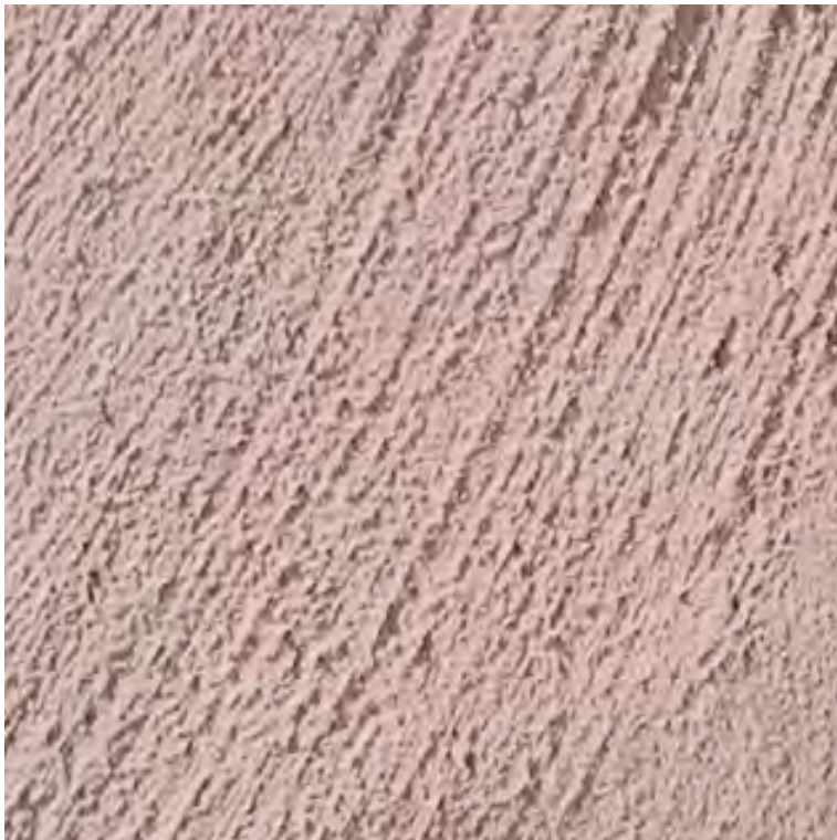
Lehmputzstruktur clay plaster structure
